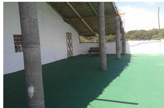
Das Haupthaus 2014 nach der Renovierung
